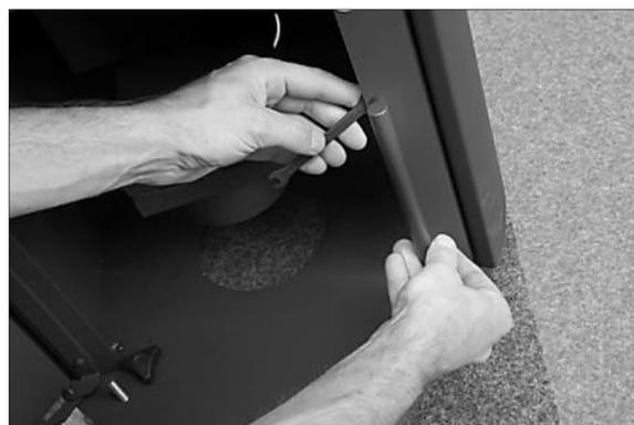
Den festen Rauchrohrstutzen durch beigelegten drehbaren ersetzen.
